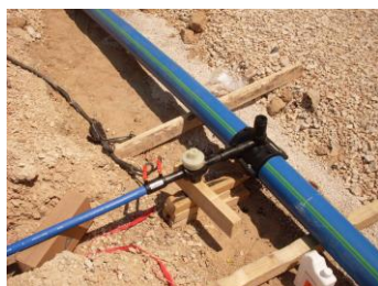
Conectarea conductei de bransament la rețeaua publica prin intermediul prizei de apa, si vana de concesi
