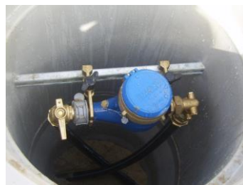
Contor de apa montat in interiorul caminului de bransament
